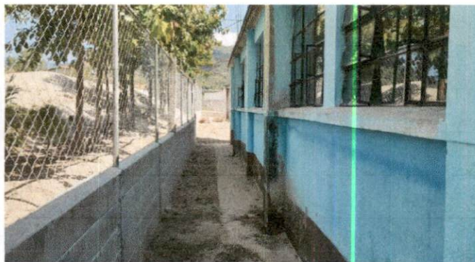
Foto1: Mejoramiento del muro perimetral del lado norte del instituto finalizado.
