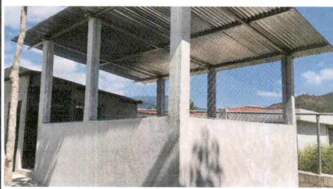
Foto 2: Mejoramiento en el tallado de columnas de concreto de la cocina finalizado.
